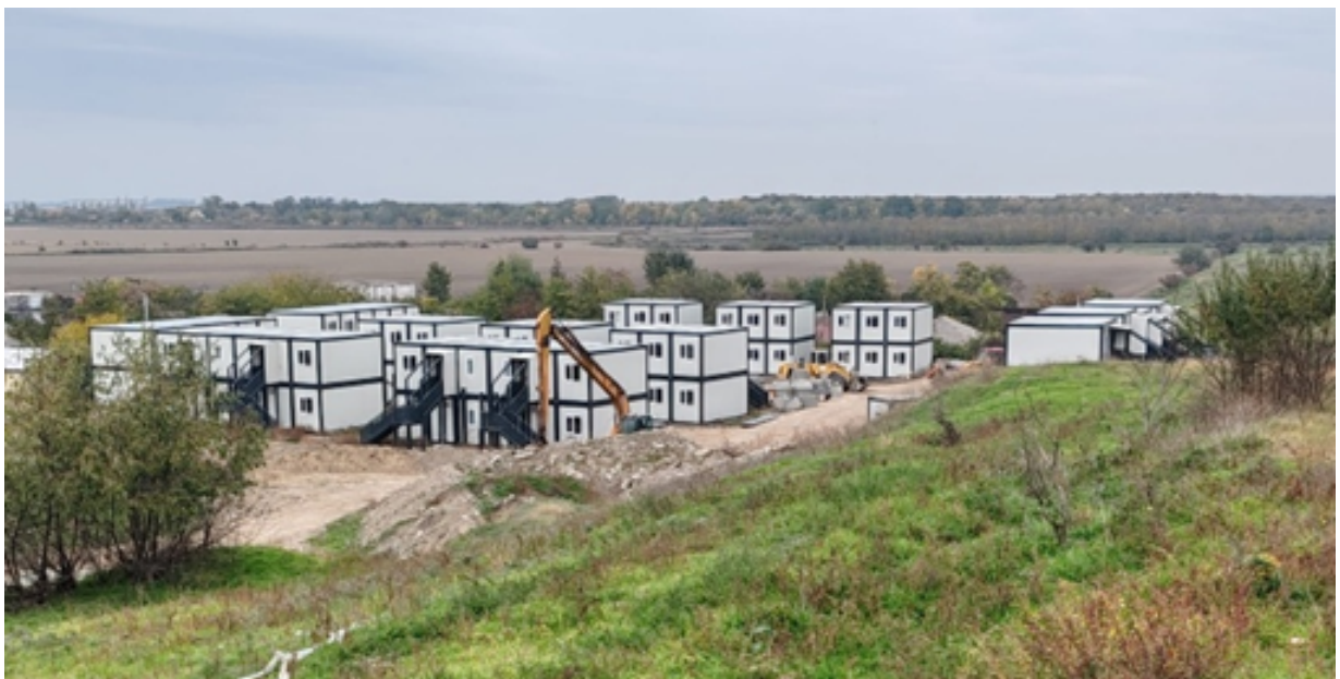
Locuinte din containere pentru romi - Catalin Berescu
