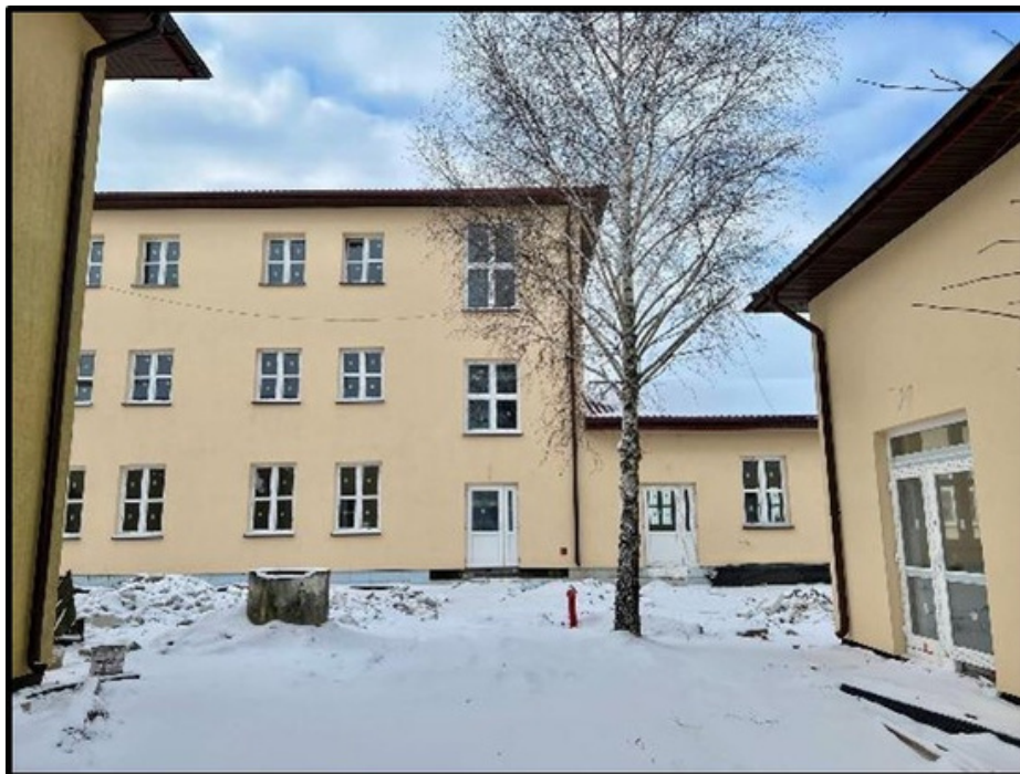
Zdjęcie 24. Zdjęcie budynków w trakcie rozbudowy (zdjęcie w głębi kompleksu)
