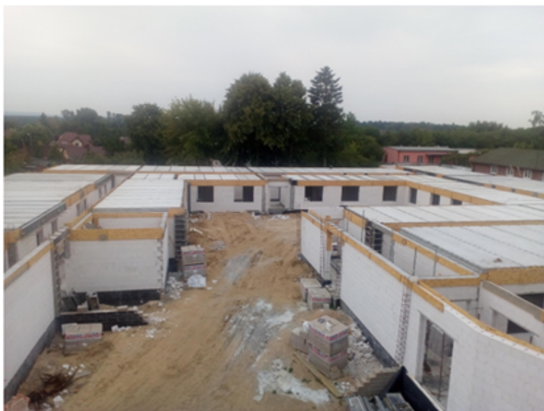
Zdjęcie nr 4. Plac budowy - nowy rozbudowywany budynek Domu Pomocy Społecznej.
