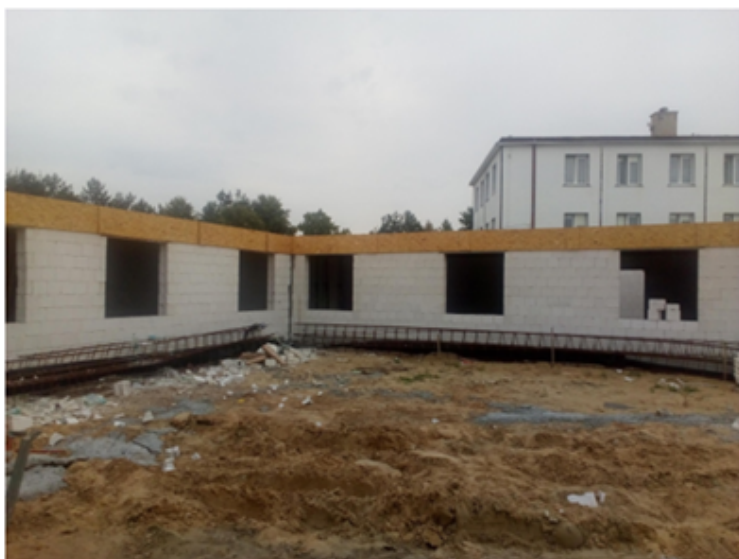
Zdjęcie nr 3. Plac budowy – nowy rozbudowywany parterowy budynek z zewnątrz
